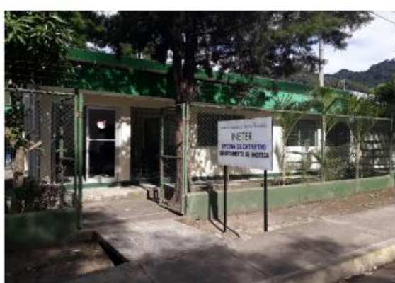
+ CONSTRUCCIÓN DE 2 NUEVAS DELEGACIONES DEPARTAMENTALES
