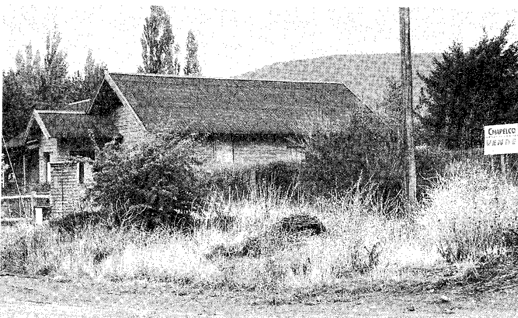
UN LOTE EN BARRIO ALJHUÉN PASÓ DE PAGAR 46 A 916 PESOS ANUALES POR LA MEDIDA DE CATASTRO PROVINCIAL.
